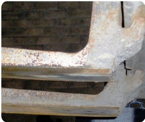
Usura prossima a compromettere la sicurezza
